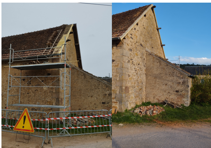
Rénovation du toit de l'atelier communal par Claude
