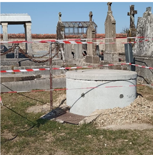
Réparation du puits du cimetière par Patrick et Gérard Vénuat
