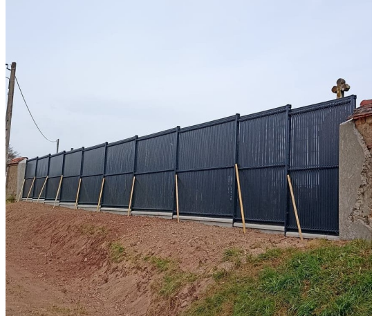
Réparation mur du cimetière par l'entreprise Palin Espaces Verts
