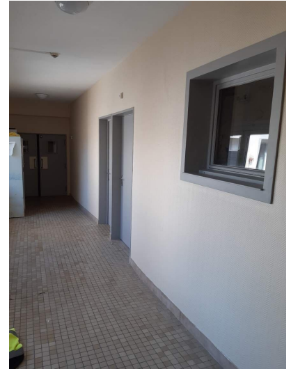
Réfection par Jean Michel du couloir derrière la cuisine de la maison de retraite de La Chesnaye.
